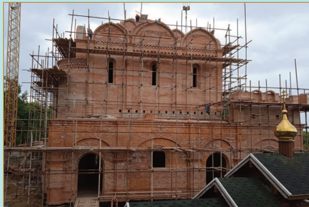
Окончание возведение стен и сводов храма. Июль 2022 года
