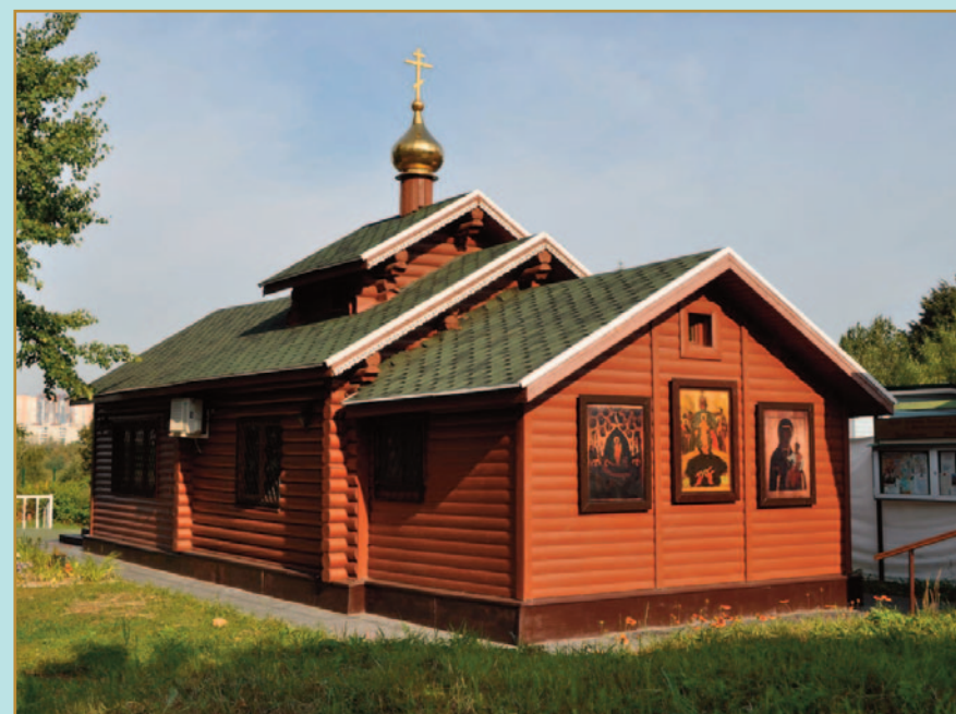
Храм после расширения алтаря и пристройки трапезной
