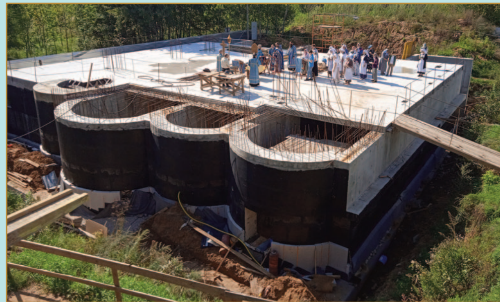
Молебен на праздник Успения Богородицы на плите перекрытия строящегося храма
